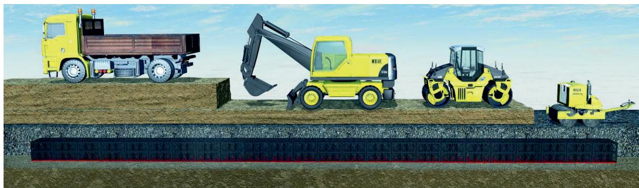
Vous pourrez utiliser différents engins de chantier pour remblayer la fouille. Il est interdit de rouler directement sur les éléments de l'ouvrage avec des compacteurs qu'ils soient ou non en train de vibrer, en raison des charges dynamiques supplémentaires exercées sur l'ouvrage.
