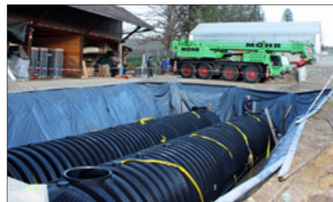
Vor dem Einsetzen der Tanks wurde in 3,6 m Tiefe das Kiesbett angelegt.
