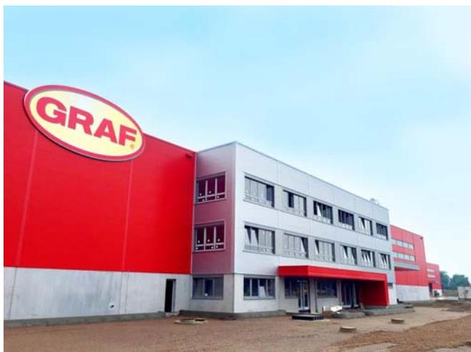
*Un bâtiment d'une surface plancher de 24 000 m<sup>2</sup> et 12 silos pour matières premières d'une hauteur de 30 mètres sont en cours de construction sur le terrain de 6,5 hectares situé à Herbolzheim.*
