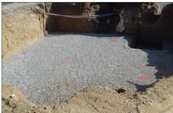
Préparation de la fouille : lit de gravillons sur 10 cm.
