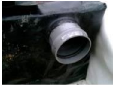
Figure 3c – Système GRAF ECOBLOC FLEX INSPECTABLE équipé d'un évent DN/OD 200
