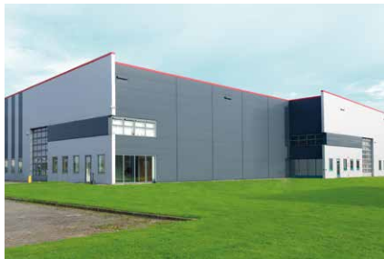
Hale magazynowe z towarami palnymi
