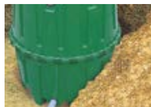
Installa il serbatoio
