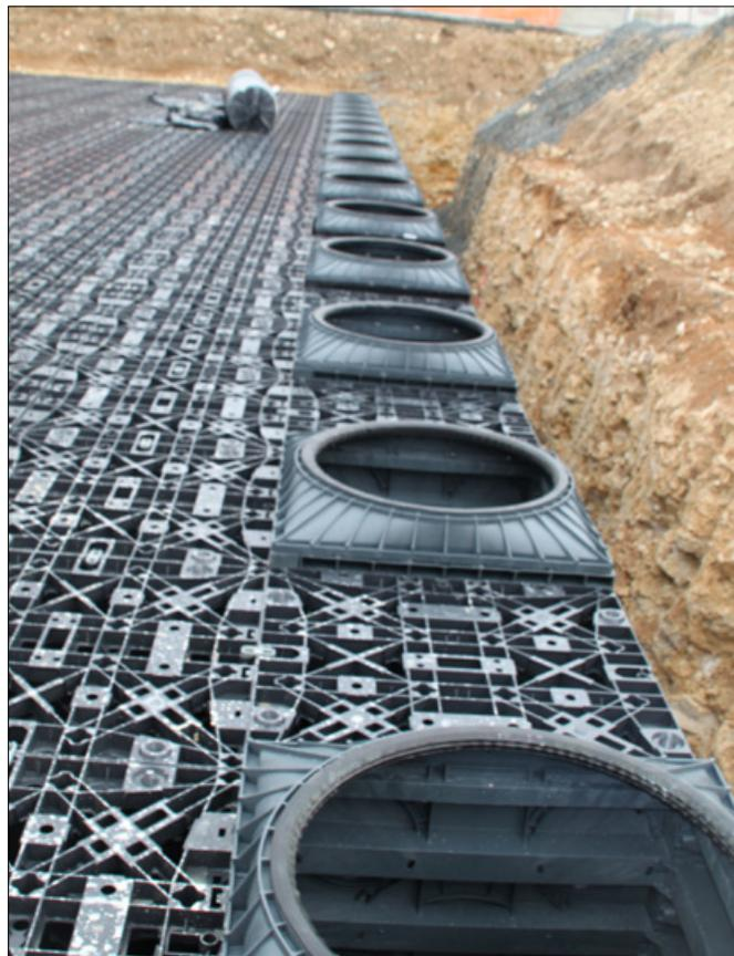
Le regard Vario 800 peut être installé à n'importe quel endroit du bassin. Il supporte une charge de passage identique au bassin et les surfaces de raccordement sont parfaitement ajustées aux EcoBloc Flex.
