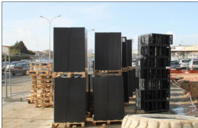
Les modules EcoBloc sont empilables, ce qui permet d'en optimiser le transport.
