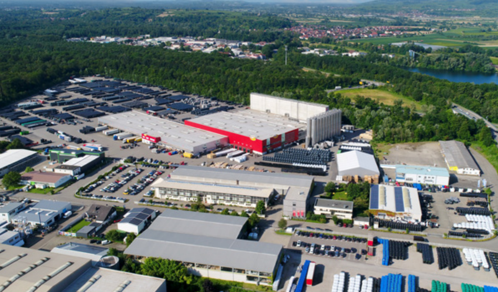
Sede central de Teningen en Friburgo
