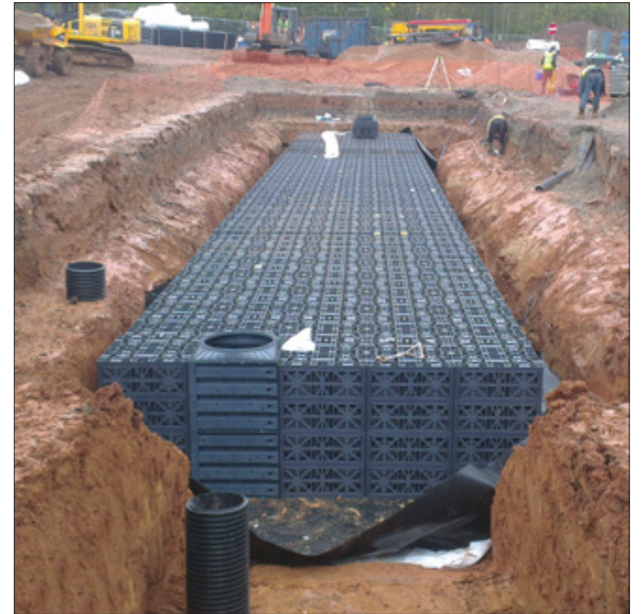
Estación productora de energía, Warwick (UK)
