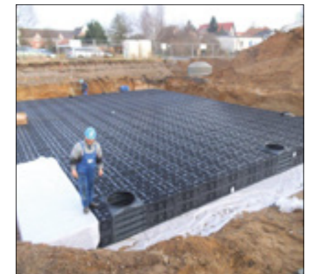
Edificio industrial, Merseburg (AL)
