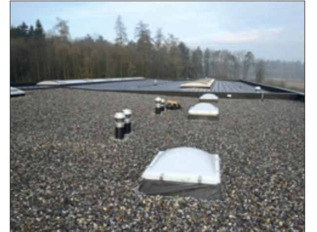
Après avoir été scellé par un recouvrement en EPDM, 2 500 m<sup>2</sup> de toiture ont été recouverts de gravier, afin de faciliter la collecte de l'eau.
