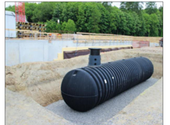
Le procédé de fabrication de la cuve lui assure une stabilité exceptionnelle et permet une installation dans la nappe phréatique jusqu'à l'équateur de la cuve. La cuve Carat XXL supporte un passage camions jusqu'à 40 tonnes.
