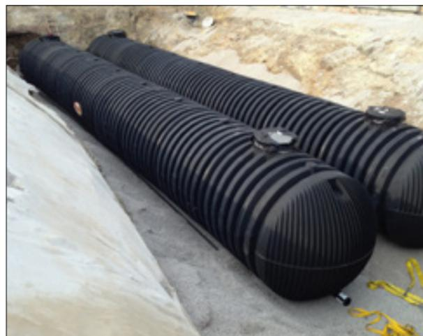
Les cuves Carat XXL peuvent supporter un passage camions jusqu'à 40 T. avec seulement 1 mètre de remblai.
