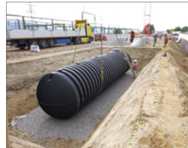
Grâce aux sangles de levage incluses dans la livraison, la cuve a été directement installée dans la fosse grâce à une seule grue mobile.
