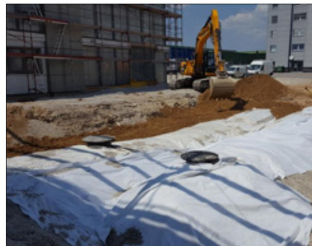
Au total 5 jours ont suffi pour les travaux d'excavation et la réalisation du lit de pose et de la dalle de répartition.
