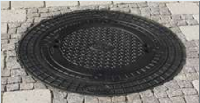
Tampa acessível de carro permite montagem abaixo da entrada no pátio
