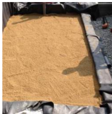
Mise en place du sable
