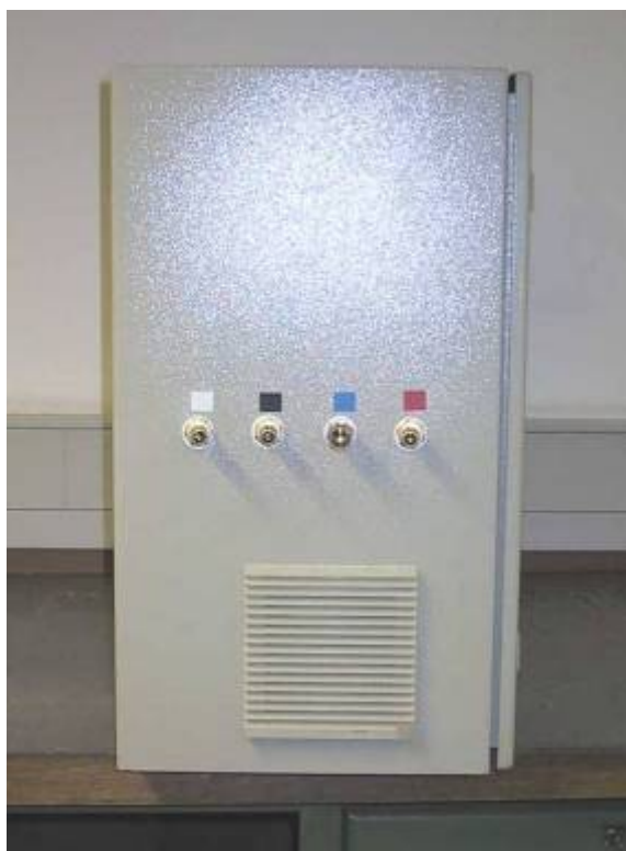
Vue de côté de l'armoire de pilotage interne. Code couleurs pour le branchement des tuyaux d'air sur les raccords.
