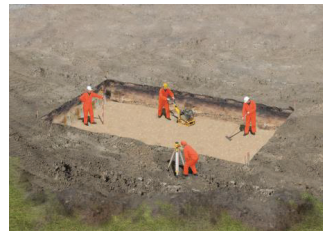
Abbildung 5: Erstellung des Planums
