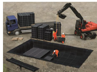
Abbildung 7: Positionieren der Rigolelemente
