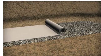
Abbildung 6: Geotextil auslegen
