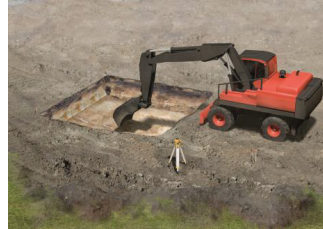
Abbildung 4: Ausheben der Baugrube
