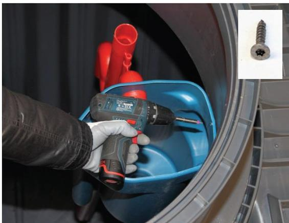
Probeentnahmebehälter mit Spax-Schraube am Tankdom befestigen
