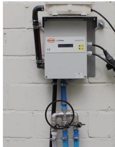
Conectar la manguera para la extracción de agua depurada (1/2") directamente en la boquilla negra del cuadro de control. Conectar el distribuidor de aire adicional en la boquilla azul del cuadro de control (3/4").
