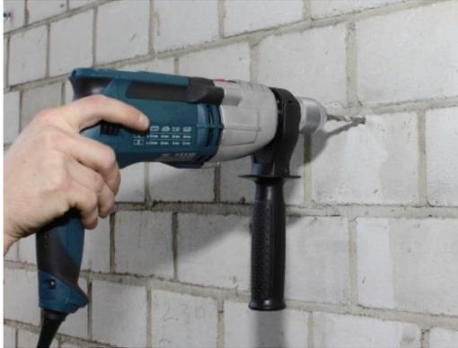
Die Steuerung ist in einem trockenen und staubfreien Innenraum zu installieren. Zur Montage sind zwei Bohrungen 8 mm in die Wand zu bohren.
