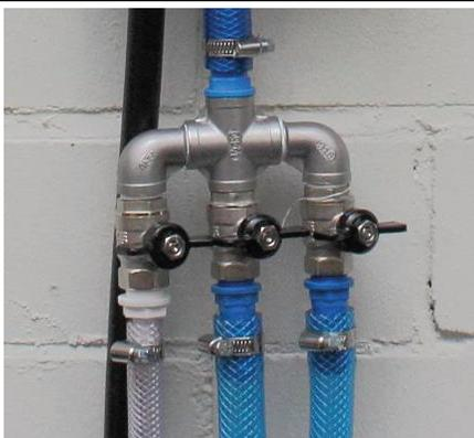
Conectar las mangueras de aireación en las dos boquillas de 3/4". Conectar la manguera para la recirculación del lodo en la conexión 1/2".
