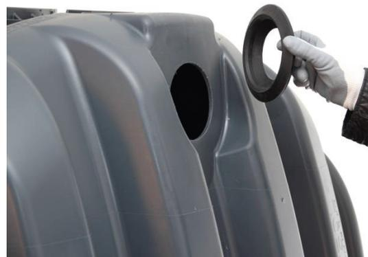
Eliminar las rebabas de los agujeros realizados. Colocar la junta DN 110. El sentido de la junta debe coincidir con el sentido de la tubería.
