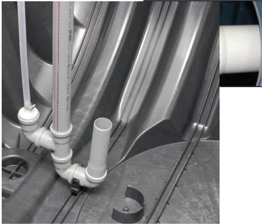
Inserire il sistema di recupero dei fanghi nel gancio di fissaggio e fissare ulteriormente con una vite Spax. Nella parte superiore del serbatoio, infilare il sistema di recupero dei fanghi nell'apposito tubo.
