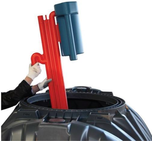
Heber mit Probeentnahme in den Tank einsetzen.
