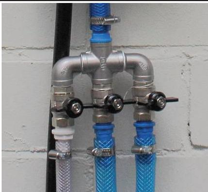
An die zwei 3/4" Schlauchtüllen werden die Schläuche für die Belüftung angeschlossen. An den 1/2" Anschluss wird der Schlauch für die Schlammrückführung angeschlossen.
