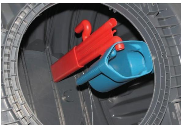
Infilare il bocchettone di uscita dell'unità di campionamento nel manicotto del tubo di uscita (utilizzare un lubrificante!). Il raccordo a manicotto deve essere fissato con viti Spax.
