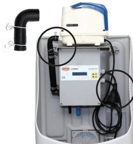
Der Verdichter wird auf die Steuerung gestellt. Zum Luftanschluss ist der Gummi-Winkel zu verwenden. Zum Stromanschluss wird der Stecker des Verdichters in die Buchse der Steuerung gesteckt.
