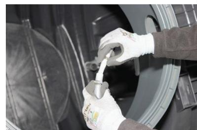
Luftschlauch (13mm) am Heber für den Klarwasserabzug anschließen. Luftschlauch (13mm) am Heber für die Schlammrückführung anschließen.
