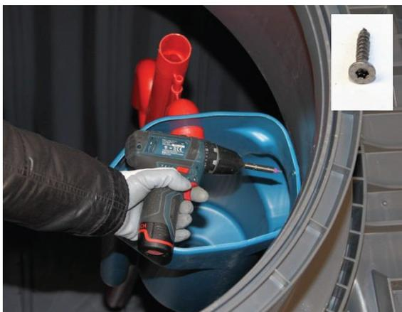
Fijar la toma de muestras con el tornillo Spax en la cúpula del depósito
