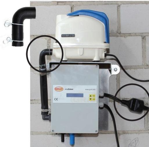
Der Verdichter wird auf die Steuerung gestellt. Zum Luftanschluss ist der Gummi-Winkel zu verwenden. Der Stecker des Verdichters wird in die Buchse der Steuerung gesteckt.
