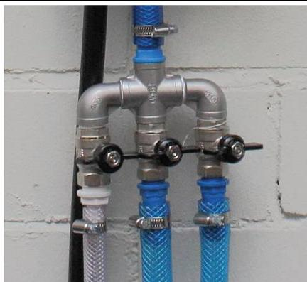
Ai due portagomma da 3/4" vengono collegati i tubi flessibili per l'aerazione. Al raccordo da 1/2" viene collegato il tubo flessibile per il recupero dei fanghi.
