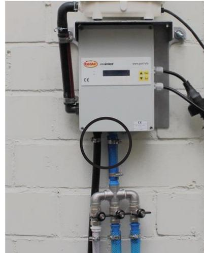
Die Schlauch für den Klarwasserabzug (1/2") wird direkt an die schwarze Schlauchtülle an der Steuerung angeschlossen. An die blaue Schlauchtülle der Steuerung (3/4") wird der Zusätzliche Luftverteiler angeschlossen.
