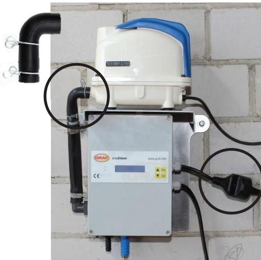
Colocar el compresor sobre el soporte de la parte superior del cuadro de control. Utilizar el codo de goma para la conexión de aire. Conectar el enchufe del compresor en el conector hembra del cuadro de control.
