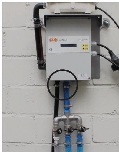
Il tubo per l'estrazione dell'acqua chiarificata (1/2") viene collegato direttamente al portagomma nero sulla centralina. Al portagomma blu sulla centralina (3/4") viene collegato il distributore supplementare d'aria.
