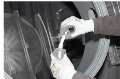
Conectar la manguera de aire (13 mm) en el sifón para la extracción de agua depurada. Conectar la manguera de aire (13 mm) en el sifón para la recirculación del lodo.
