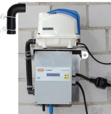
Il compressore viene posizionato sopra la centralina. Per il collegamento dell'aria utilizzare il gomito in gomma. Collegare la spina del compressore alla presa della centralina.
