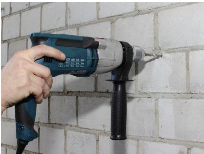
El panel de control debe instalarse en un espacio interior seco y limpio. Para el montaje, hay que taladrar dos perforaciones de 8 mm en la pared.
