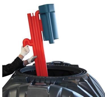
Heber mit Probeentnahme in den Tank einsetzen.
