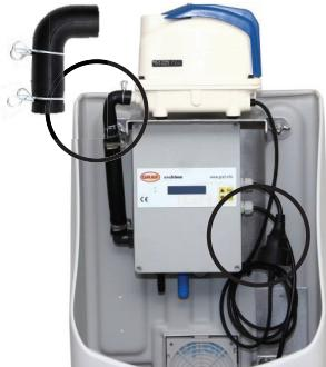
Ubicar el compresor encima del panel de control y conectarlos haciendo uso del codo de 90 grados; asegurar con las abrazaderas incluidas.
