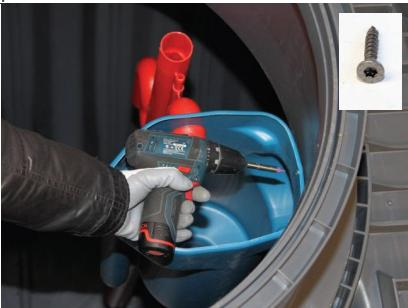
Fijar el depósito de la toma de muestra a la cúpula con tornillo Spax
