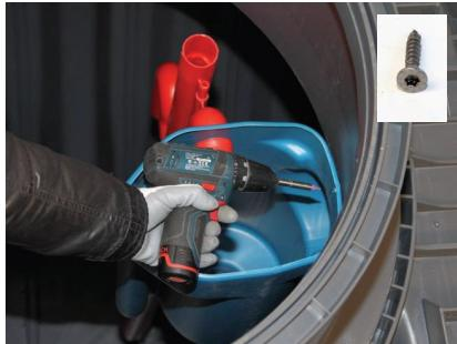
Fissare il contenitore per il campionamento alla torretta del serbatoio utilizzando una vite Spax.
