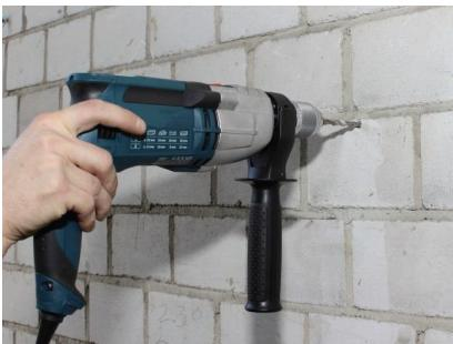
La centralina deve essere installata in un locale chiuso, asciutto e privo di polvere. Per il montaggio è necessario eseguire due fori da 8 mm nella parete.
