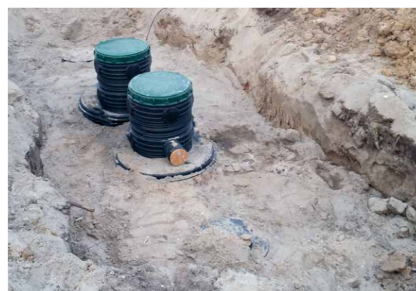
Rysunek 2. Oczyszczalnia actibio podczas montażu.
