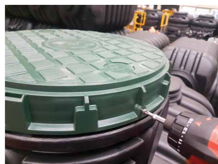
2. Umieścić wkręty INOX 4.8x32 w otworach znajdujących się w pokrywie, następnie wkręcić je
