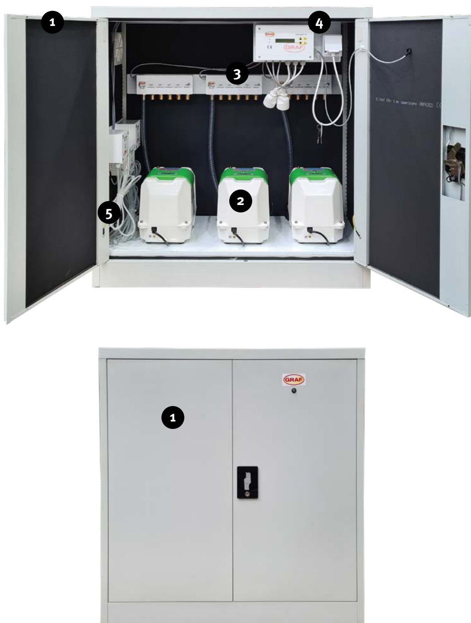
Zespół sterowania dla urządzeń od 21 RLM - skrzynka otwarta i zamknięta.
