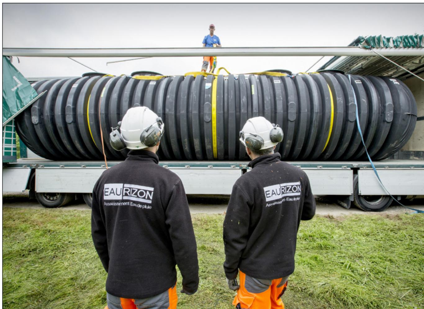
L'installation de la micro-station easyOne seule (terrassment, déchargement, raccordement, remblai) a nécessité quant à elle seulement 3 jours. La station est équipée d'un système de surveillance (inclus avec toutes les stations de plus de 20 EH de la marque GRAF) permettant de vérifier son bon fonctionnement à distance.
