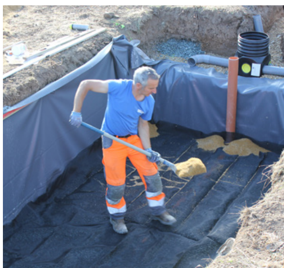
Faible empreinte au sol : 11 m 2 pour le filtre compact 6 EH, 22 m 2 pour le 12 EH
