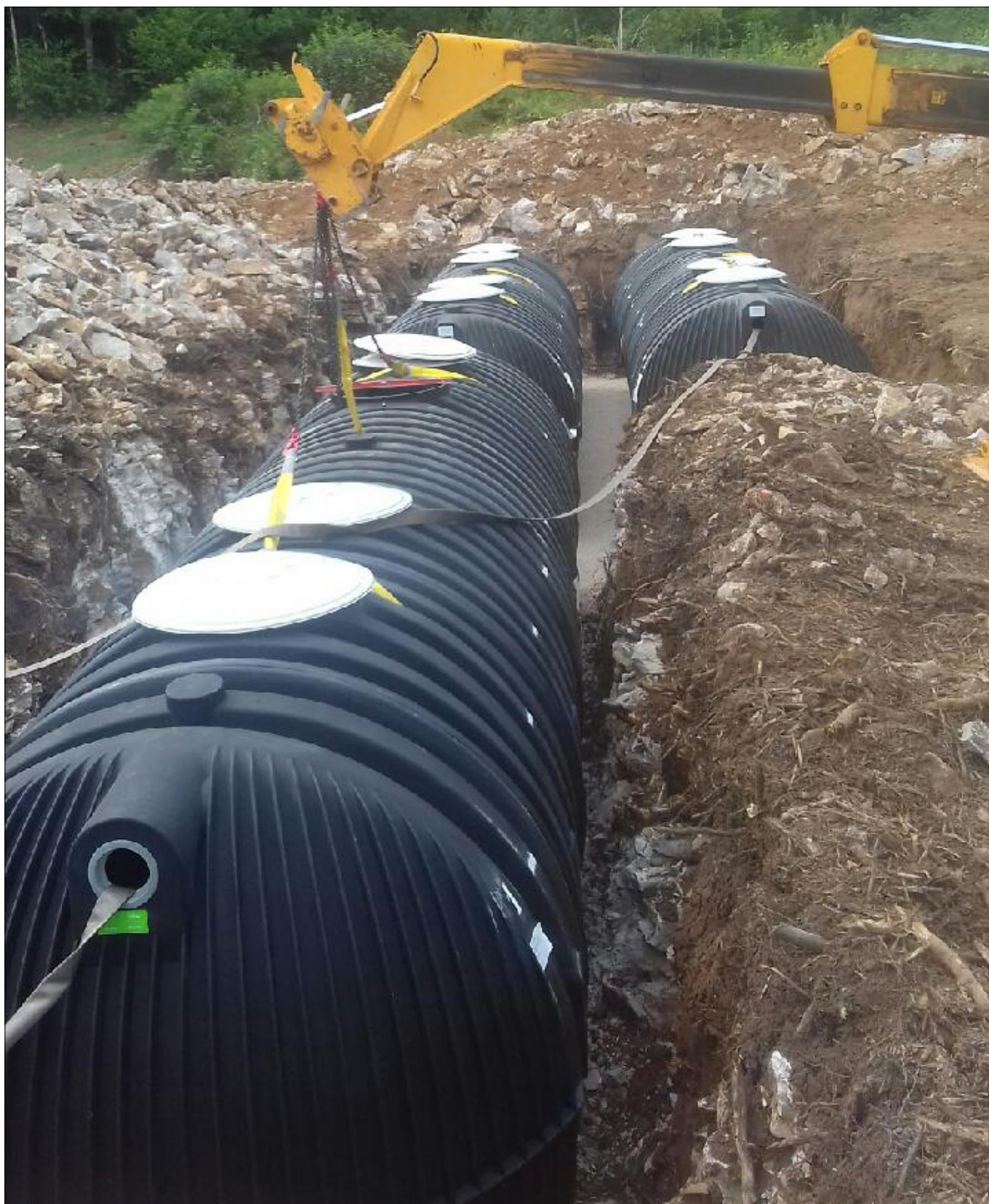
La station est composée de trois cuves PE de 44 000 litres.
