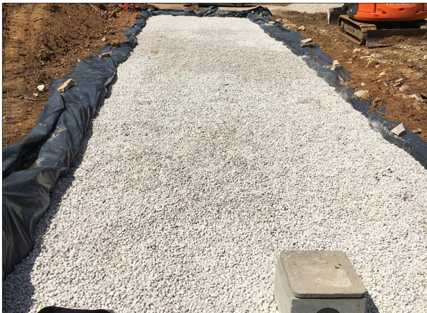
Un bassin de tunnels d'infiltration a été installé en sortie de station afin d'infiltrer l'eau épurée.
