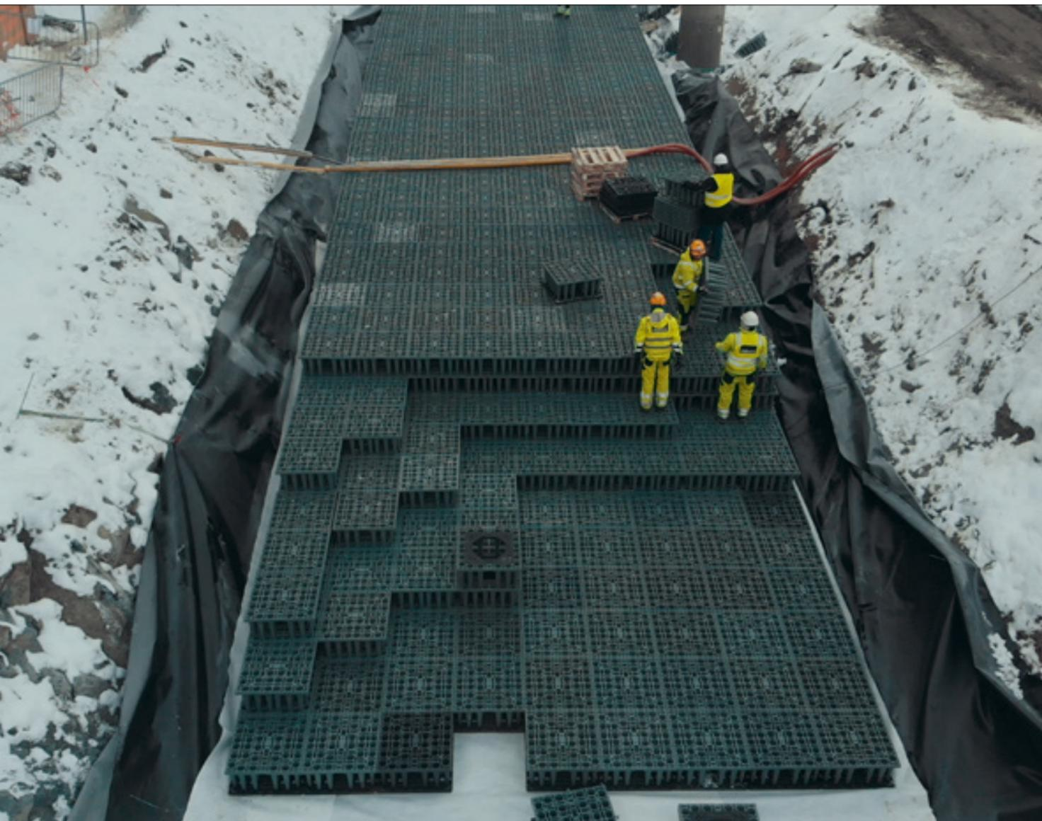
Dal tetto e dai parcheggi circostanti, l'acqua piovana confluisce nel sistema di ritenzione, dove viene temporaneamente raccolta per poi essere scaricata in un fiume attiguo tramite un pozzetto con valvola.
