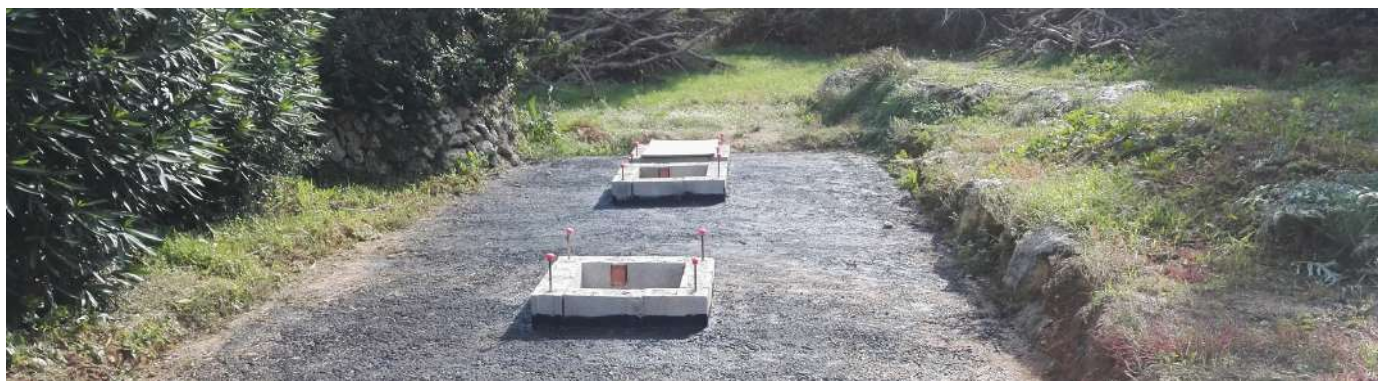
Vista anterior al recubrimiento final de la instalación del equipo.
