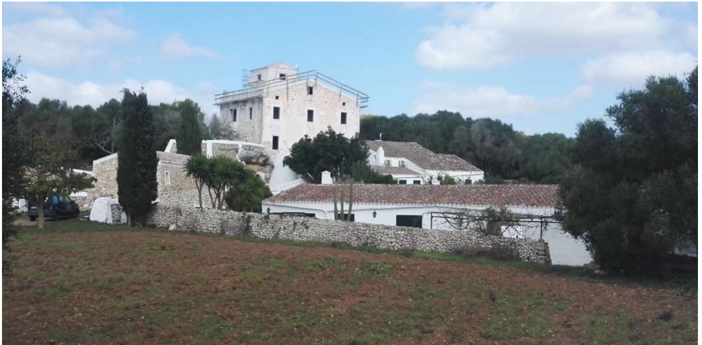
Vista general del edificio principal de la casa de Agroturismo Rafal Rubí en Menorca
