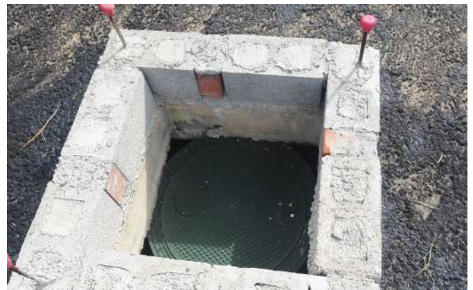
Vista de un registro de la depuradora con la construcción de una arqueta de obra accesoria
