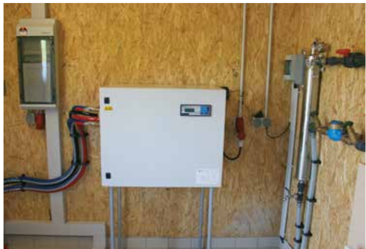
Podłączenie elektryczne, szafa sterownicza, moduł UV
