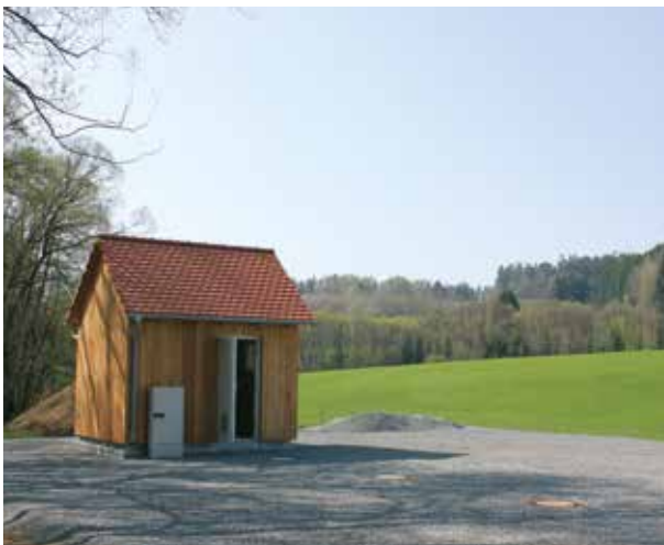
Budynek techniczny w pobliżu oczyszczalni
