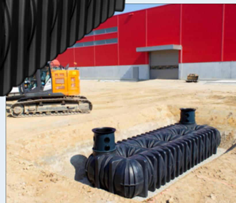
\*Carrabile per autocarro con copertura carrabile apposta per autocarri in associazione con piastra di distribuzione del carico
