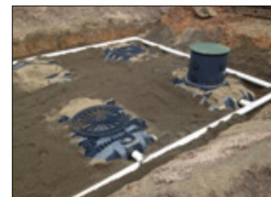
L'immagine mostra un esempio con serbatoio di estensione. I tubi di collegamento sono da posizionarsi a cura del committente.
