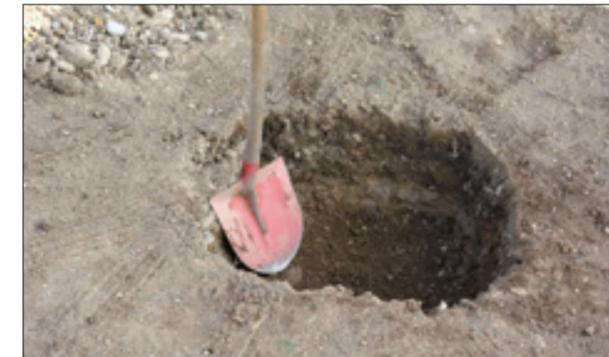
1. Eine Grube in den Abmessungen 500 x 500 x 500 mm ausheben. Der Boden sollte eben sein. Die Grube ca. 30 Minuten wässern, um den Boden anzufeuchten. Vor Beginn des Versuchs muss die Grube komplett entleert werden.
