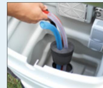
Das Leerrohr muss mindestens auf der Seite des Schaltschranks verschlossen werden, so dass ein Gasaustausch über dieses Rohr ausgeschlossen ist (Seite 103).
