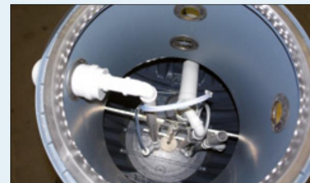
Vormontierter Rüstsatz für Zweibebehälter-Anlage
