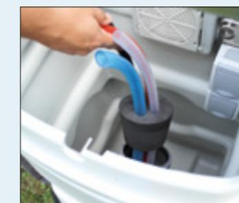
Das Leerrohr muss mindestens auf der Seite des Schaltschranks verschlossen werden, so dass ein Gasaustausch über dieses Rohr ausgeschlossen ist (Seite 87).
