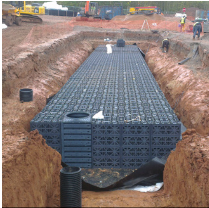
Dostawca energii, Warwick (UK)
