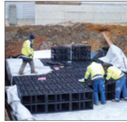
Budynek przemysłowy, Tumeltsham (AT)
