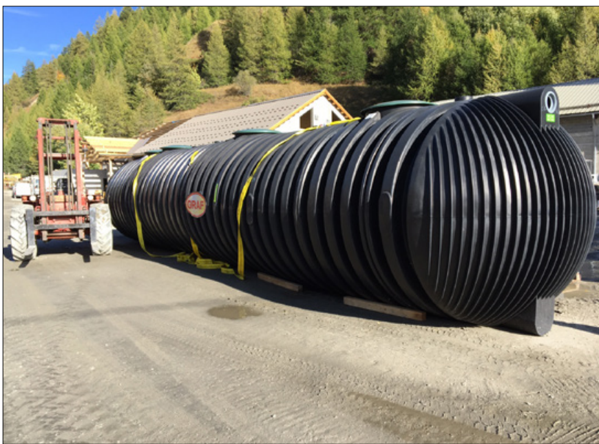
Une seule cuve de 54 000 L a été nécessaire pour ce projet, ce qui a permis de limiter les coûts du terrassement.
