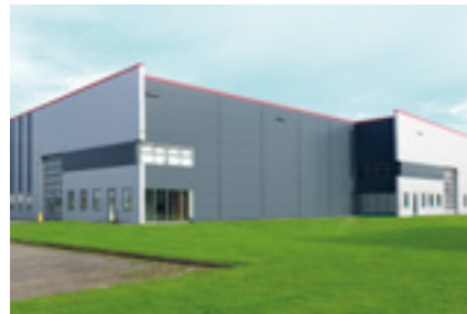
Lagerhallen mit brennbaren Gütern
