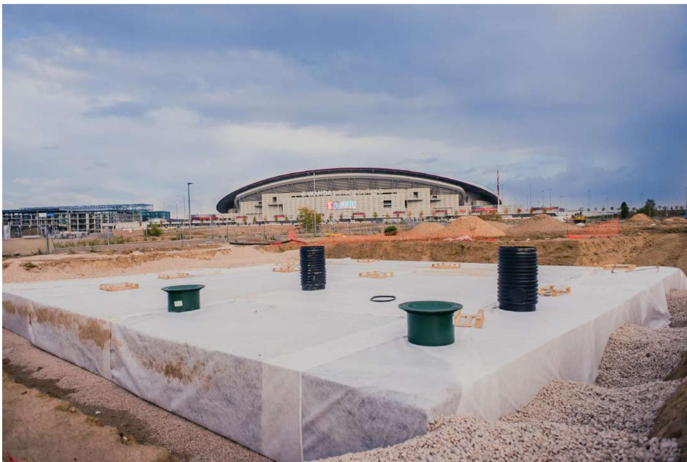
Y el **depósito de 145m<sup>3</sup>** de capacidad está equipado con Ecobloc Maxx y Arqueta Vario 800 Flex y cubierta peatonal.
