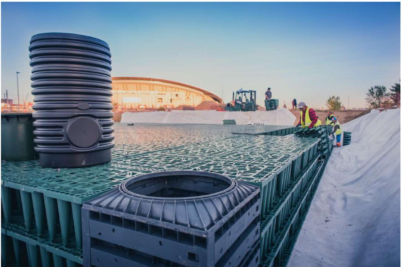
**Los depósitos** de 200m<sup>3</sup>, 100m<sup>3</sup> y 55m<sup>3</sup> de capacidad, están equipados con Ecobloc Light y Arquetas Vario 800 Flex y cubierta peatonal
