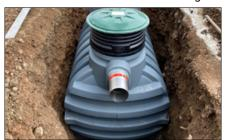
según la normativa de construcción para el tratamiento de aguas residuales que contengan aceites minerales (aguas pluviales, aguas residuales y condensados). En las unidades de lavado no solo se limpia la suciedad visible de los vehículos, sino también los restos de aceite y grasa.
