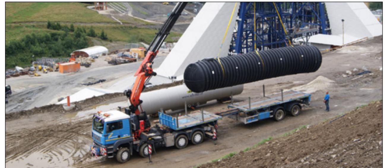
Das Brauchwasser für das Tunnelbaulos Fröschnitzgraben wird in vier GRAF Kunststofftanks mit zusammen 224.000 l Fassungsvermögen gespeichert.
