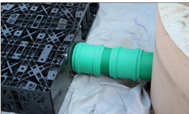
Das Niederschlagswasser wird aus dem Substratfilter mit einem KG-Rohr DN 250 in die Versickerungsanlagen geleitet. (Foto: GRAF)
