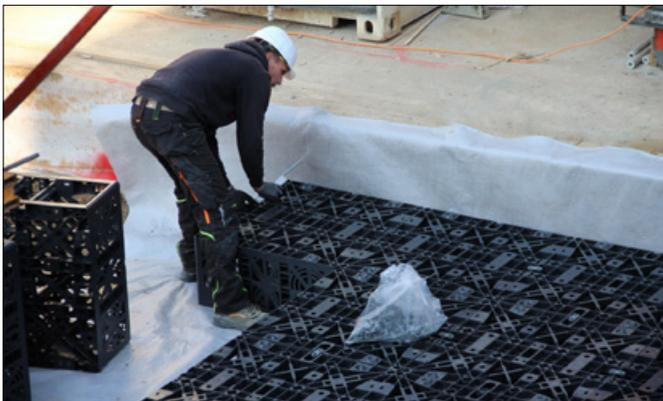
Aus 670 Modulen GRAF EcoBloc Inspect 230 ist eine Anlage von 114,8 m Länge, 3,20 m Breite und nur 36 cm Höhe entstanden. (Foto: GRAF)
