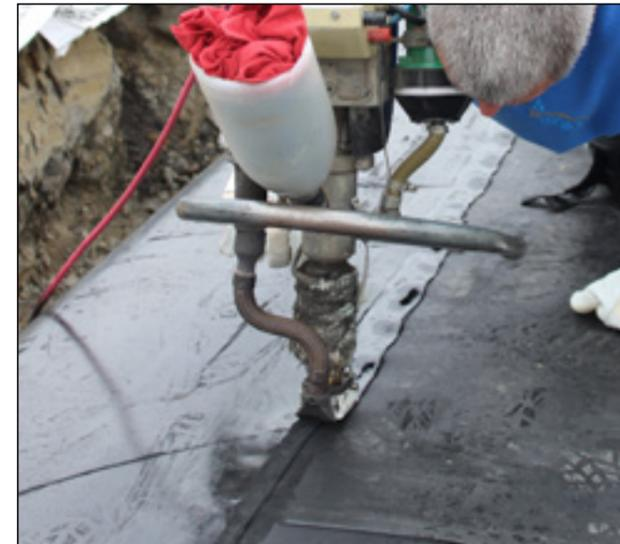
Die innere Schicht wurde mit einer wasserundurchlässigen 2-mm-HDPE-Folie verschweißt.
