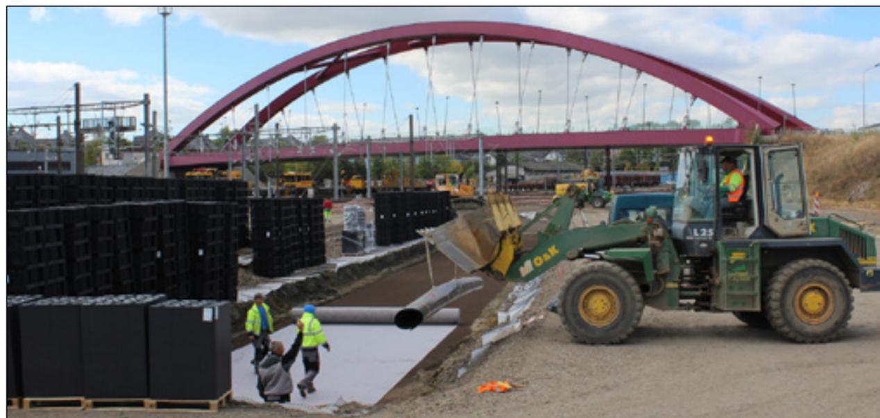
Für das Bauvorhaben wurden die Module innerhalb von fünf Arbeitstagen vor Ort zu einem dreilagigen Blockverbund montiert und in Folie eingeschweißt
