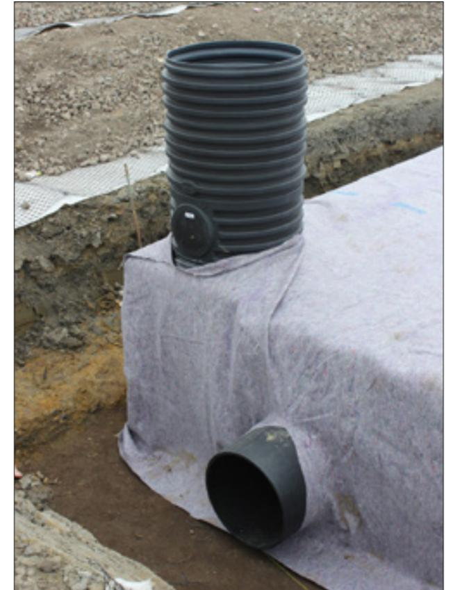
Das GRAF Vario 800 Schachtsystem lässt sich frei und ohne statische Einschränkung in dem EcoBloc Inspect flex System positionieren.
