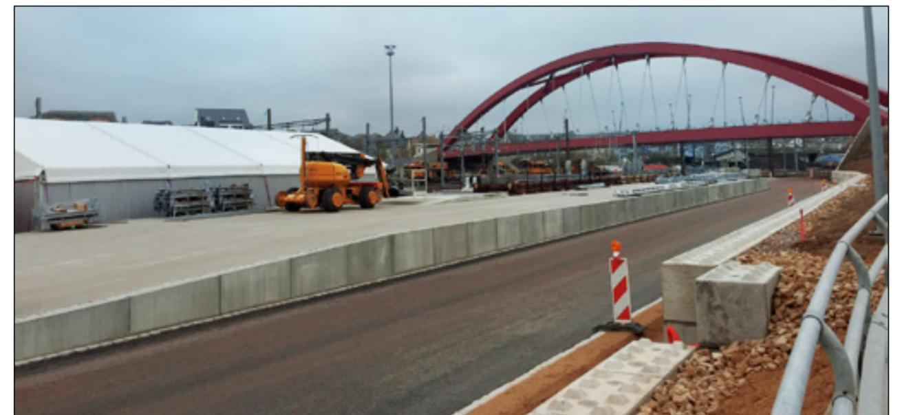
Die Module wurden unter einer Lkw-Laderampe eingebaut, daher war es für die Planer entscheidend, dass eine Befahrbarkeit nach SLW 60 realisiert werden kann.
