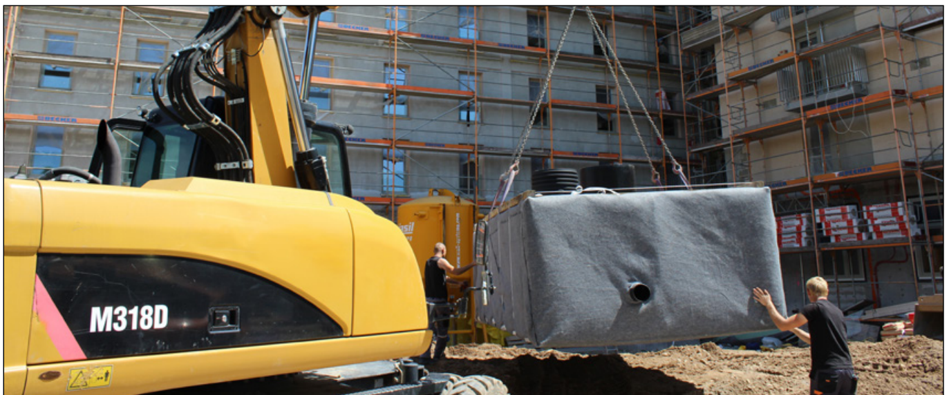
Der Rigolenkörper kann problemlos mit einem Erdbagger in die vorbereitete Grube gehoben werden.
