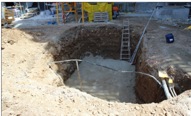
Die vorkonfektionierte Retentionsanlage wird just in time auf die Baustelle geliefert.
