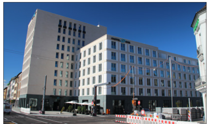
Das Niederschlagswasser der angeschlossenen Dach- und Bodenflächen des Design-Budget-Hotels wird in ein unterirdisches Regenrückhaltesystem aus Graf EcoBloc Inspect Modulen geleitet.
