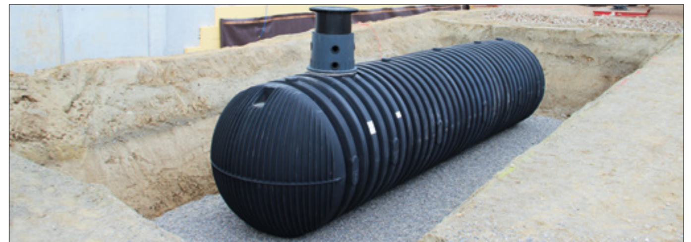
Die Konstruktion des Behälters sorgt für hohe Stabilität und ermöglicht so den Einbau bis zur Tankmitte in das Grundwasser. Der Carat XXL ist für eine Lkw-Befahrbarkeit mit bis zu 40 t Gesamtgewicht ausgelegt.
