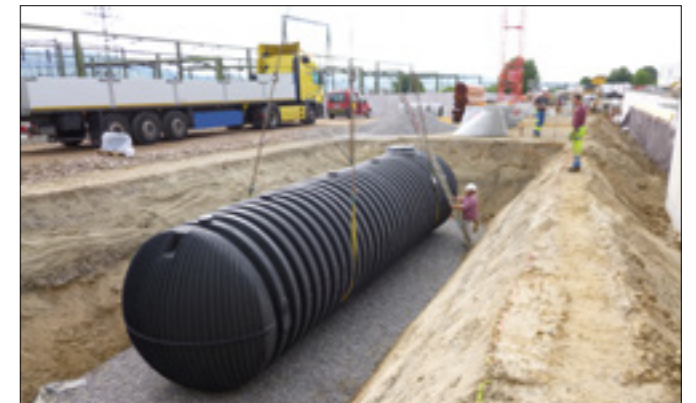
Der Kunststofftank GRAF Carat XXL wurde mit einem Autokran „in einem Stück“ eingebracht und in Kies eingebettet. Die für das Versetzen des Regenspeichers erforderlichen Hebeschlaufen waren bereits im Lieferumfang enthalten.
