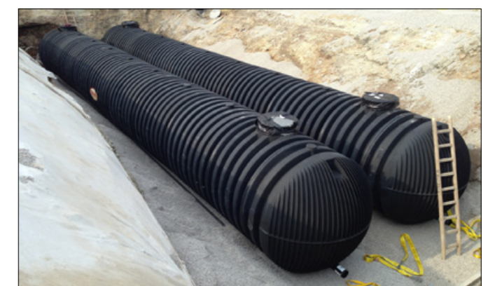
Die GRAF Erdtanks benötigen trotz einer Lkw-Überfahrbarkeit bis 40 t nur eine Überdeckung von 1 m bis zur Geländeoberkante.
