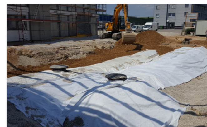
Die Aushubarbeiten der Grube, die Herstellung des Kiesbetts und der lastverteilenden Platte wurden an 5 Arbeitstagen ausgeführt.
