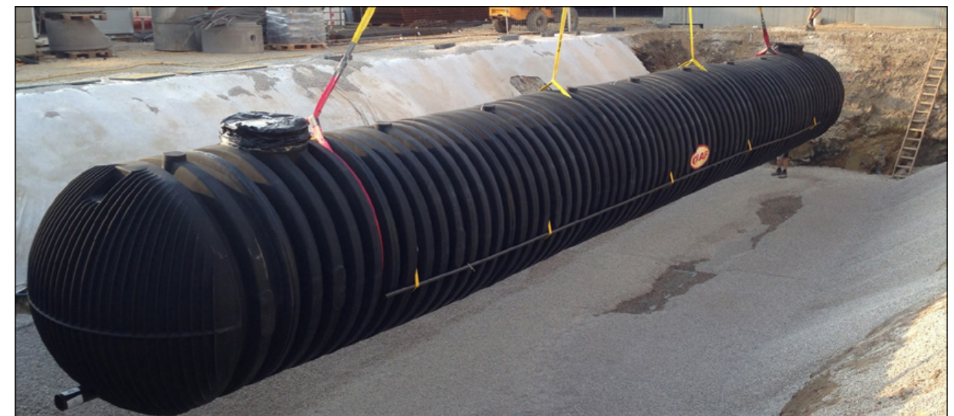
Innerhalb von nur zwei Stunden wurden die beiden Tanks von den Lkw in die Grube gehoben.
