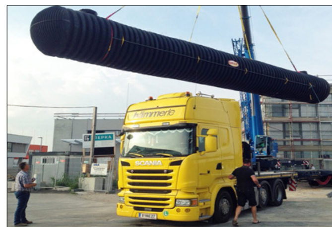
Die bislang größten von GRAF produzierten Tanks wurden mit einem Sondertransport 750 km von Teningen nach Brunn am Gebirge (Österreich) transportiert.
