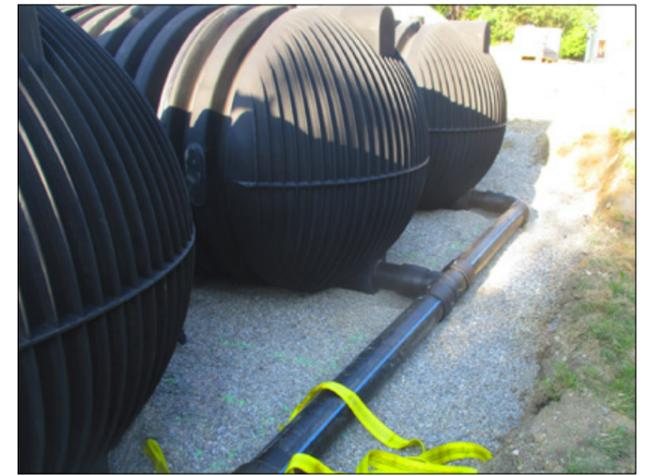
Die vier Tanks sind über Rohre mit DN 250 miteinander verbunden. Dadurch ist nur ein Entnahmestutzen erforderlich.
