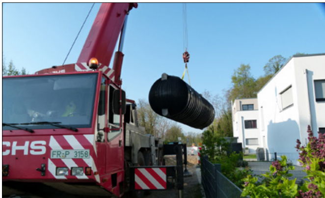
Der Löschwasserbehälter wurde mit einem Autokran an den mitgelieferten Halteschlaufen entladen. (Foto: GRAF)
