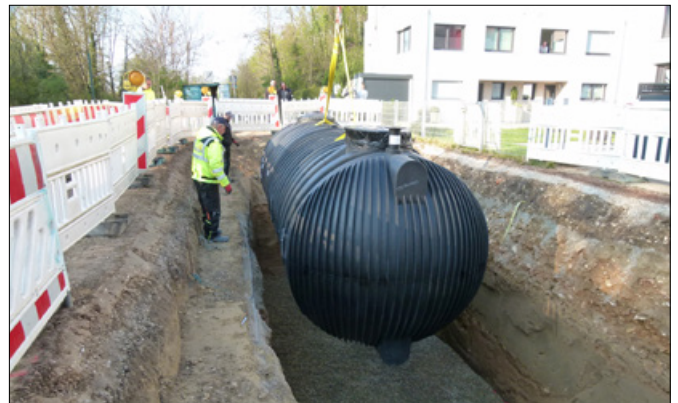
Für die Grundsole in 3,55 m Tiefe war lediglich ein Bett aus Rundkornkies (Körnung 8/16) zu erstellen. (Foto: GRAF)
