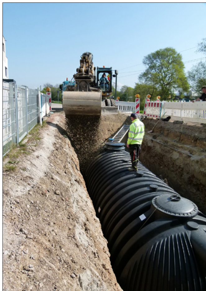
Der Behälter wurde mit Rundkornkies eingebettet und bis Unterkante Bodenplatte mit 1,00 m überdeckt. (Foto: GRAF)
