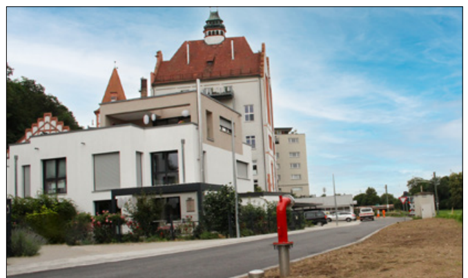
Der Entnahmestutzen und das Entlüftungsrohr sind unmittelbar neben der Straße platziert. (Foto: GRAF)
