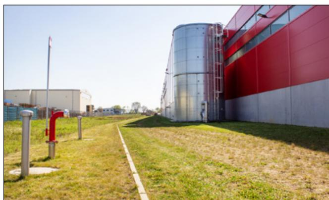
Die zwei Löschwasseranlagen des Werks bestehen aus GRAF Carat XXL Löschwasserbehälter mit einem Gesamtvolumen von 208.000 l. Die Feuerwehrzufahrt wurde aus Schotterrassen erstellt, damit bei Regen das Wasser bestmöglich versickern kann.
