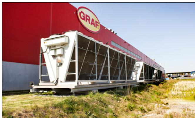
Durch das Besprühen der Freikühler mit kalkfreiem Regenwasser wird bei hohen Außentemperaturen zusätzliche Verdunstungskälte erzeugt und der Einsatz von Additiven reduziert.
