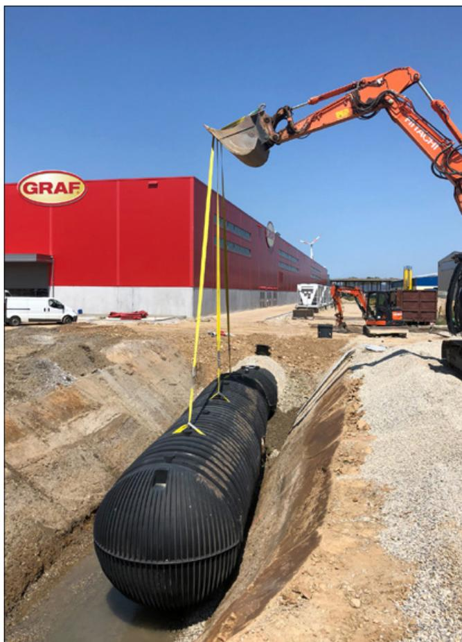
Vier GRAF Carat XXL Löschwasserbehälter mit je 52.000 l Volumen werden zur Löschwasserbevorratung genutzt.
