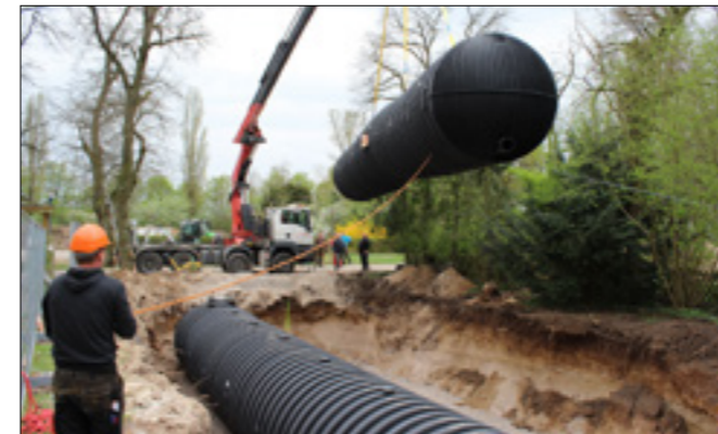
An den bereits vormontierten Hebegurten wurden die Kunststoffbehälter mit einem mobilen Kran in der Grube platziert.
