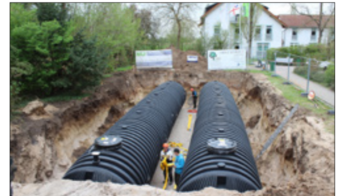
Zum Verfüllen wurde verdichteter Rundkornkies (Körnung 8/16) verwendet.
