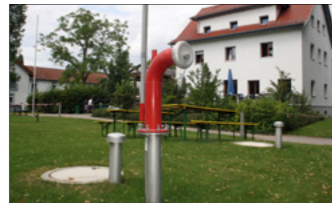
Von den unterirdischen Löschwassertanks sind nur noch die Entlüftung, der Entnahmestutzen und die Tankabdeckung sichtbar.
