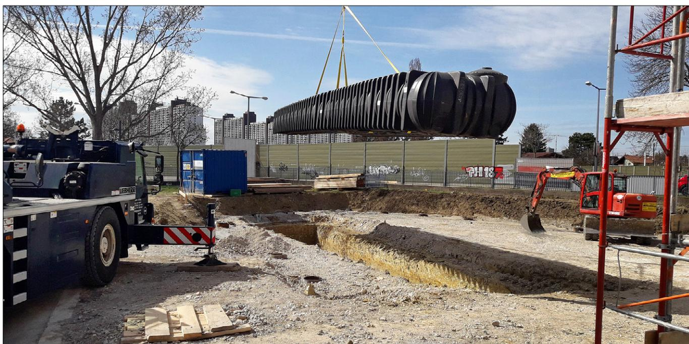
Zwei Flachtanks (18,43 x 2,25 x 1,25 m) wurden unter dem Fahrweg der Parkflächen in einer Tiefe von 3,18 m eingebaut. (Foto: GRAF)
