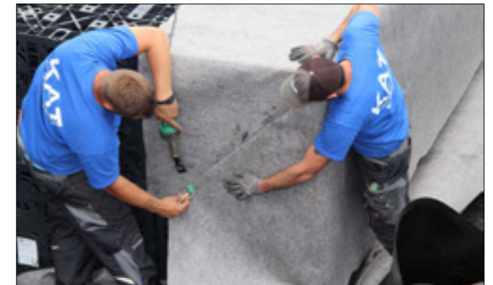
Der Blockverbund wurde im ersten Arbeitsschritt mit Geotextil eingeschlagen.
