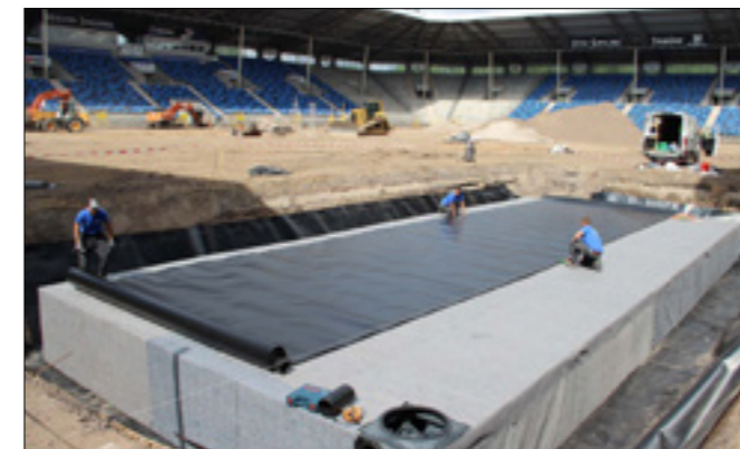
Die innere Schicht wurde in einem zweiten Arbeitsschritt mit einer wasserundurchlässigen 2-mm-HDPE-Kunststoffdichtungsbahn verschweißt.
