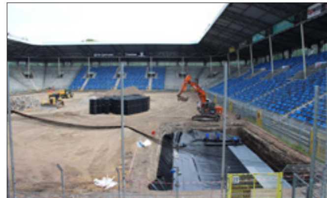
Die Einbausohle für die Regenwassernutzungsanlage wurde in einer Tiefe von 2,64 m unter Geländeoberkante vorbereitet.
