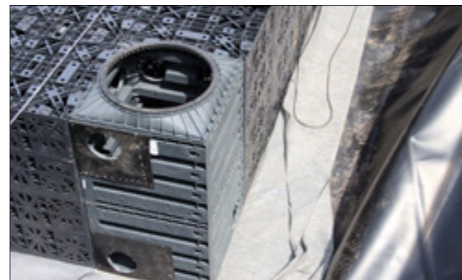
In den EcoBloc Verbund ist das Schachtsystem Vario 800 von GRAF passgenau integriert.
