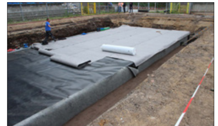
In einem dritten Arbeitsschritt wurde die Rigole nochmals mit dem Geotextil umschlossen.
