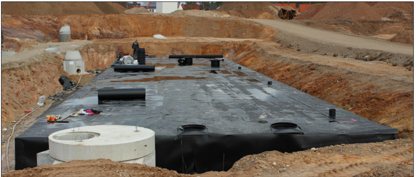
Die Rückhalteanlage entwässert eine Fläche von 23.000 m 2
