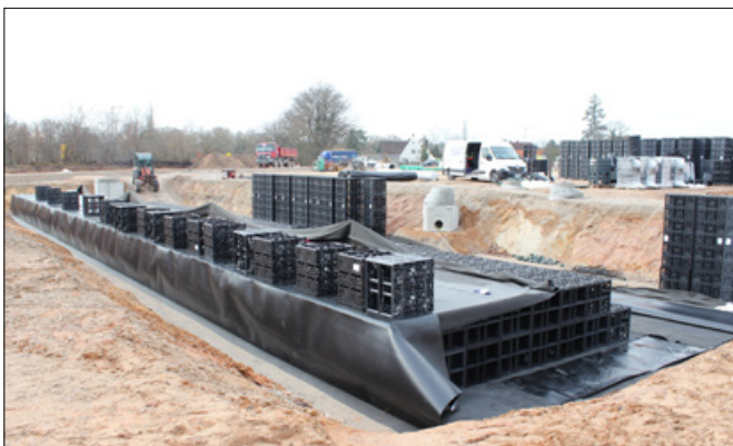
Der Rigolenkörper wurde aus 1.142 Graf EcoBloc Modulen vor Ort zu einem Blockverbund mit einem Speichervolumen von 480.000 l montiert.
