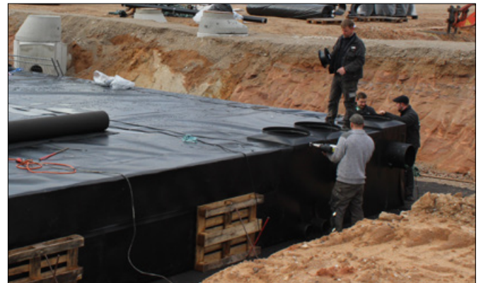
Der dreilagige Aufbau der Kunststoffdichtbahn verhindert den unkontrollierten Wasseraustritt aus den Modulen.
