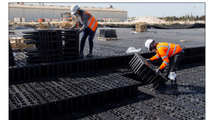
42.200 GRA EcoBloc Inspect smart Module wurden zu einem Blockverbund mit 9.029 m 3 Volumen verbunden. (Foto: GRAF)
