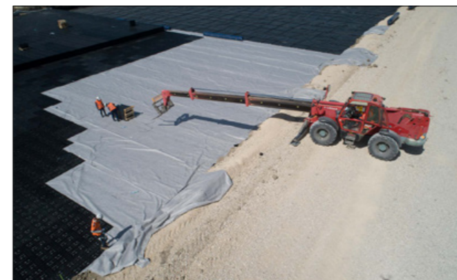
Der Blockverbund der Retentionsanlage wurde mit einem Geotextil eingeschlagen. (Foto: GRAF)
