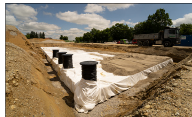
Die Schächte wurden bei GRAF bereits projektspezifisch vormontiert und anschlussfertig angeliefert. (Foto: GRAF)
