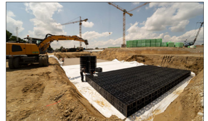
Die GRAF EcoBloc Inspect Module wurden innerhalb von nur zweieinhalb Arbeitstagen vor Ort zu einem mehrlagigen Blockverbund montiert. (Foto: GRAF)
