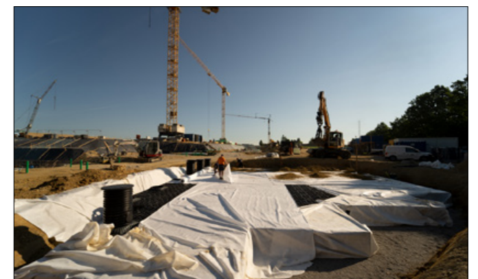
Der Blockverbund wurde anschließend mit Geotextil eingeschlagen. (Foto: GRAF)
