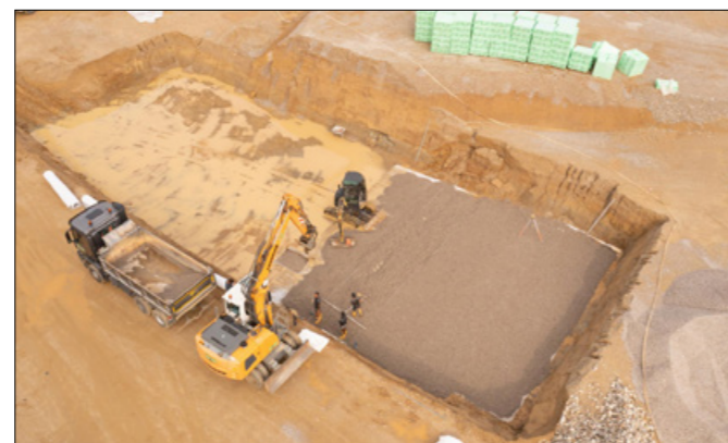
Um das Kiesbett für die Rückhalteinlage zu erstellen, musste der Grundwasserspiegel durch den Einsatz von Pumpen abgesenkt werden. (Foto: GRAF)
