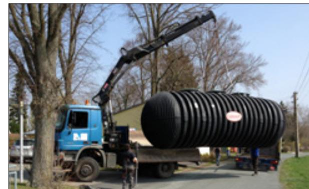
Die Klärbehälter konnten aufgrund des geringen Gewichtes mit einem Teleskopkran selbst abgeladen werden.
