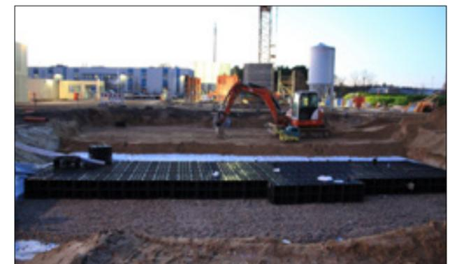
Da die statischen Eigenschaften der EcoBloc Rigole auch den Einbau in tieferen Bodenschichten bei Beibehaltung der SLW-60-Befahrbarkeit erlauben, war ein Austausch des Bodens vor der Einbringung des Rigolenkörpers nicht notwendig.
