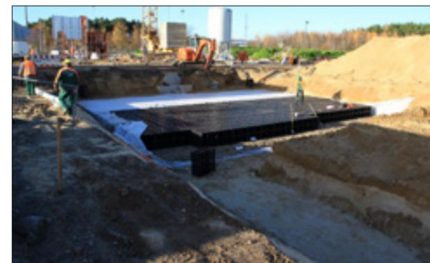
Die EcoBloc Inspect Module wurden auf einer Fläche von etwa 16 x 31 m zu einem einlagigen Blockverbund mit einer Rigolensohle von 1,90 m unter Geländeoberkante montiert.
