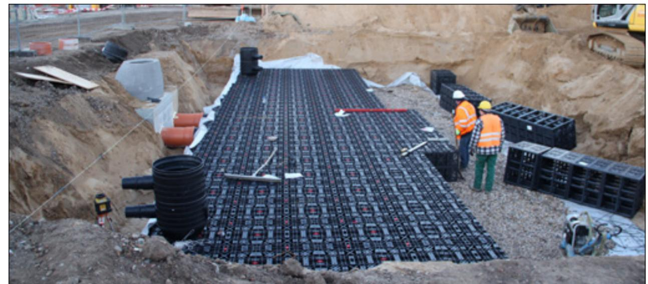
Über Sammler wird das Wasser an zwei Zulaufschächten aus Beton über zwei GRAF Adapterplatten DN 500 in die Versickerungsrigole geleitet.
