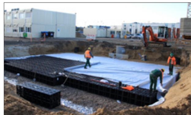
Das Regenwasser wird mit 780 GRAF EcoBloc Inspect Modulen mit einem Versickerungsvolumen von etwa 330.000 l kontrolliert versickert.
