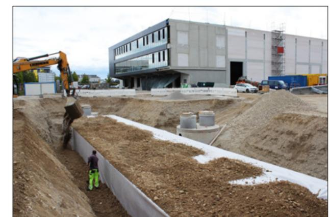
Mit der ausgeführten Erdüberdeckung von 120 cm bis Oberkante Gelände ist das Rigolensystem bis SLW 60 überfahrbar.
