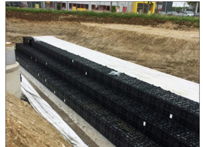
Der Rigolenkörper wurde aus 684 Graf EcoBloc Modulen vor Ort zu einem Blockverbund mit einem Speichervolumen von 287.280 l montiert.
