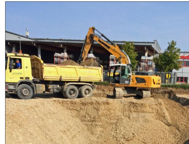
Die Spezialisten der Schneider Erd-Tiefbau GmbH, Peiting, haben für die Regenwasserversickerung eine Baugrube von 980 m<sup>3</sup> ausgehoben.
