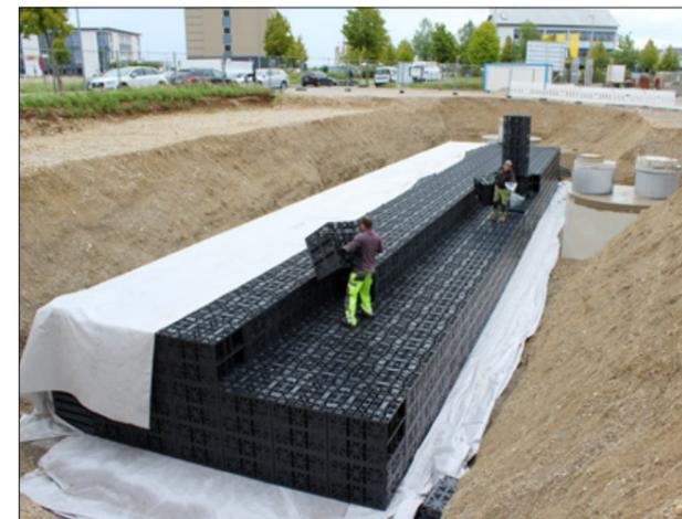
Die einfache Handhabung spart beim Rigolensystem EcoBloc Inspect 420 entscheidend Montagezeit und Kosten. Durch die vormontierten Module wird nur wenig Zubehör und kein Werkzeug benötigt.
