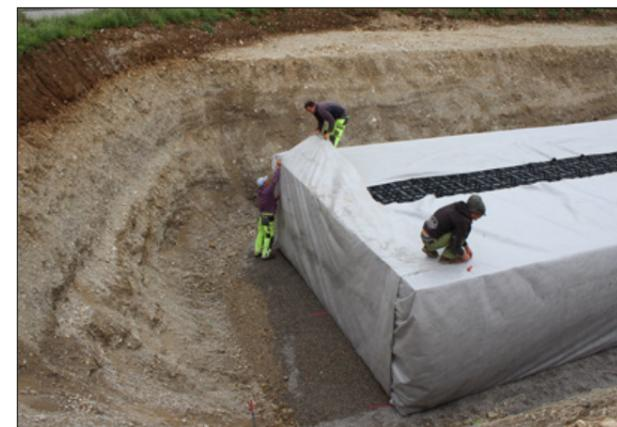
Der Rigolenkörper wurden abschließend mit Graf-Tex Geotextil umschlossen.
