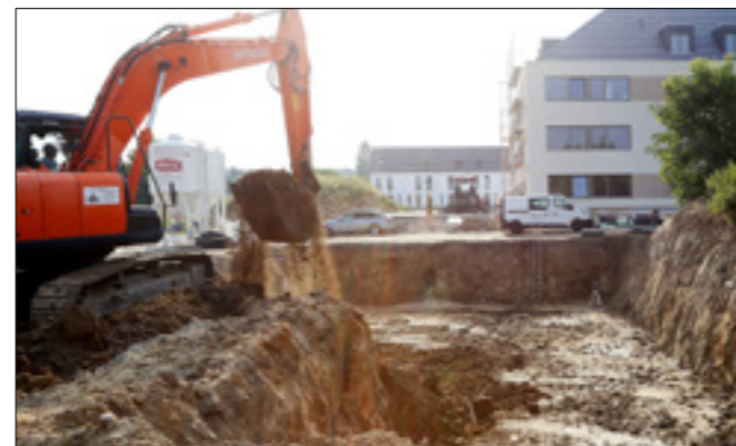
Die Spezialisten der Syrbe und Bauch Baugeschäft GmbH, Grimma, haben für das GRAF Versickerungssystem die Baugrube ausgehoben.
