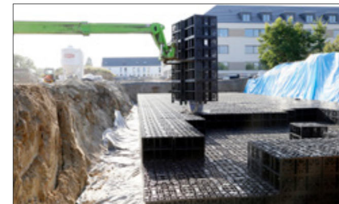
Mit einem Teleskoplader wurden die Module zur Montage eingehoben.
