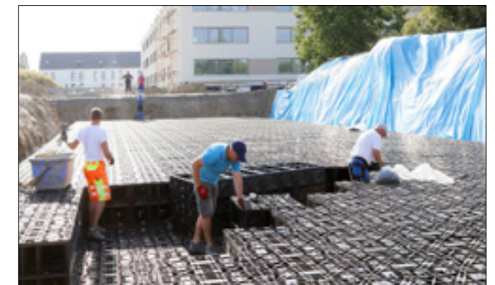
Durch die vormontierten Module werden nur wenig Zubehör und keine Werkzeuge bei der Montage benötigt.
