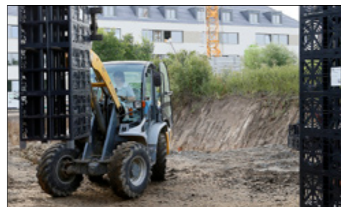
Die Module wurden vor Ort zu einem kompakten Verbund vormontiert.
