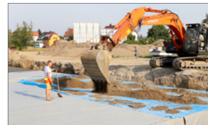
Über dem Rigolenkörper wurde, geschützt durch eine Folie, mit dem Aushub der Grube eine Überdeckung von 80 cm hergestellt.
