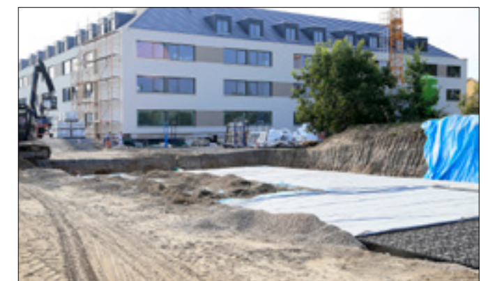
Von dem 693.410 l Regenwasser fassenden unterirdischen Versickerungssystem bleiben nur wenige Entlüftungsrohre sichtbar.
